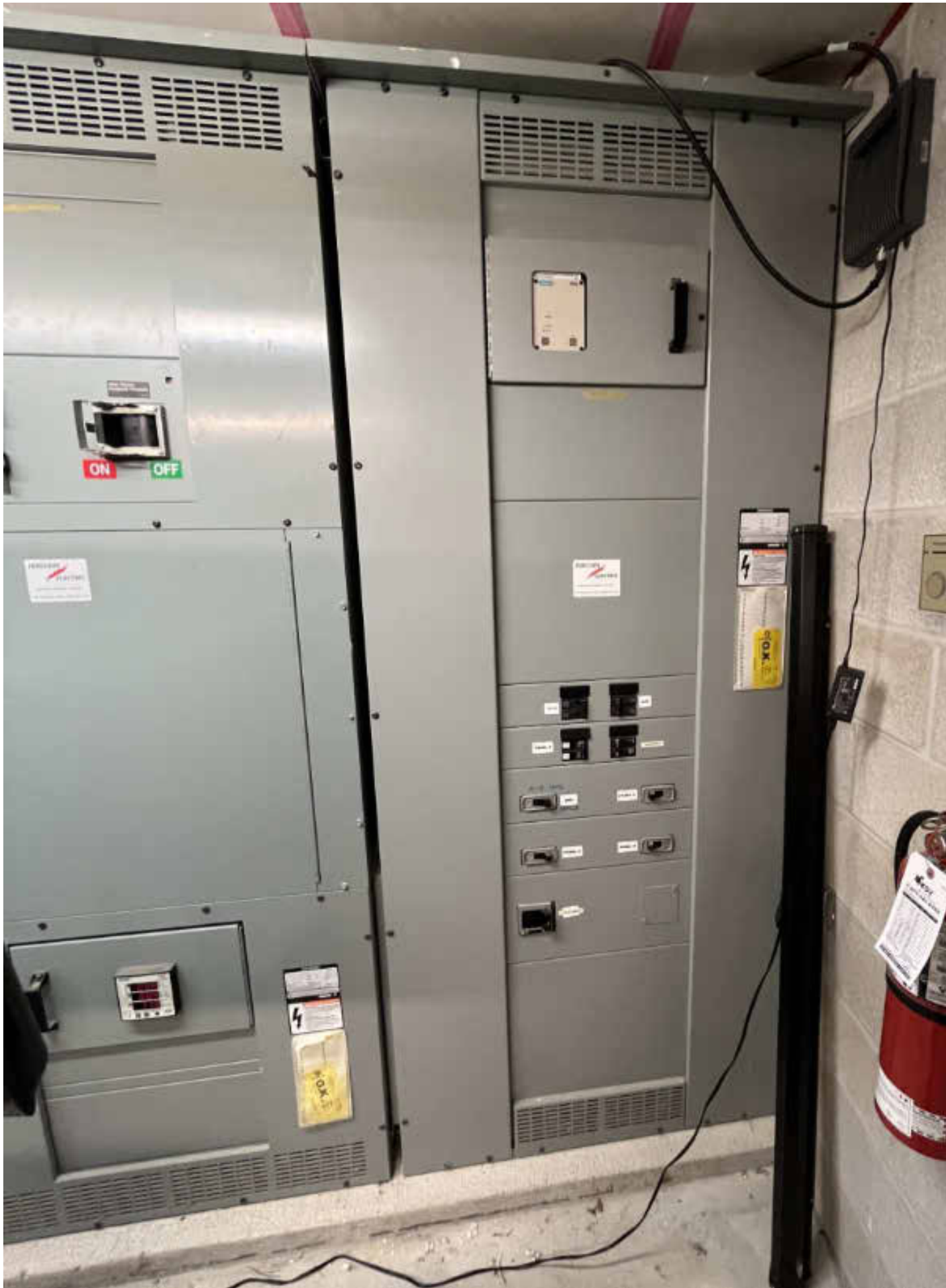
2 EXISTING SWITCHBOARD EAST SCALE: N.T.S.
